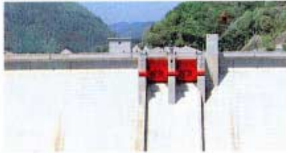
非常用洪水吐
