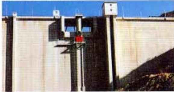
常用洪水吐・表面取水塔
