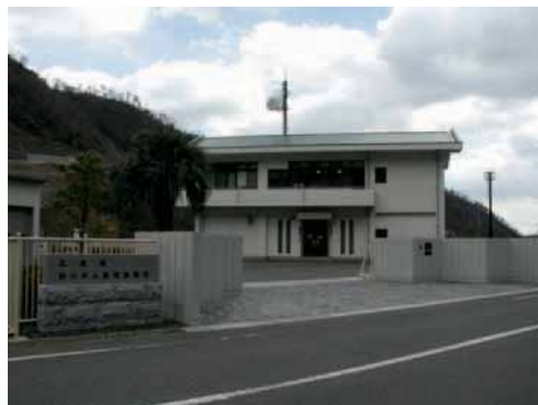
四川ダム管理事務所
