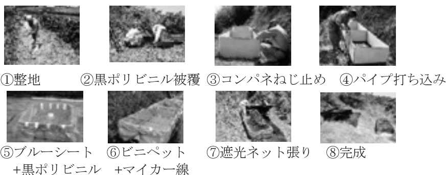
図1 組立式天水槽の現場での設置作業の様子
