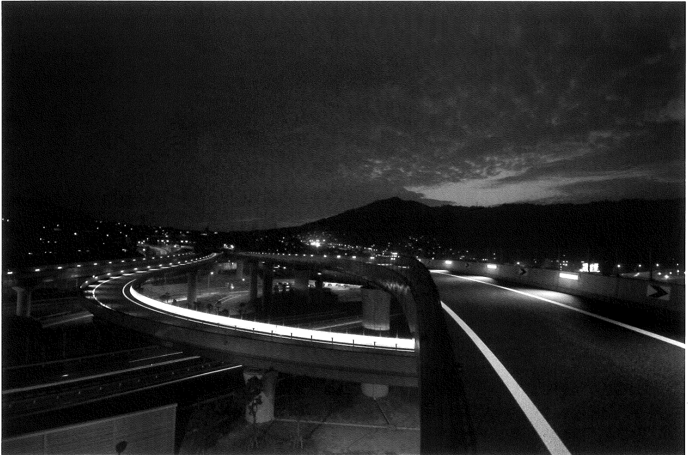
広島高速1号線（安芸府中道路）広島東IC
