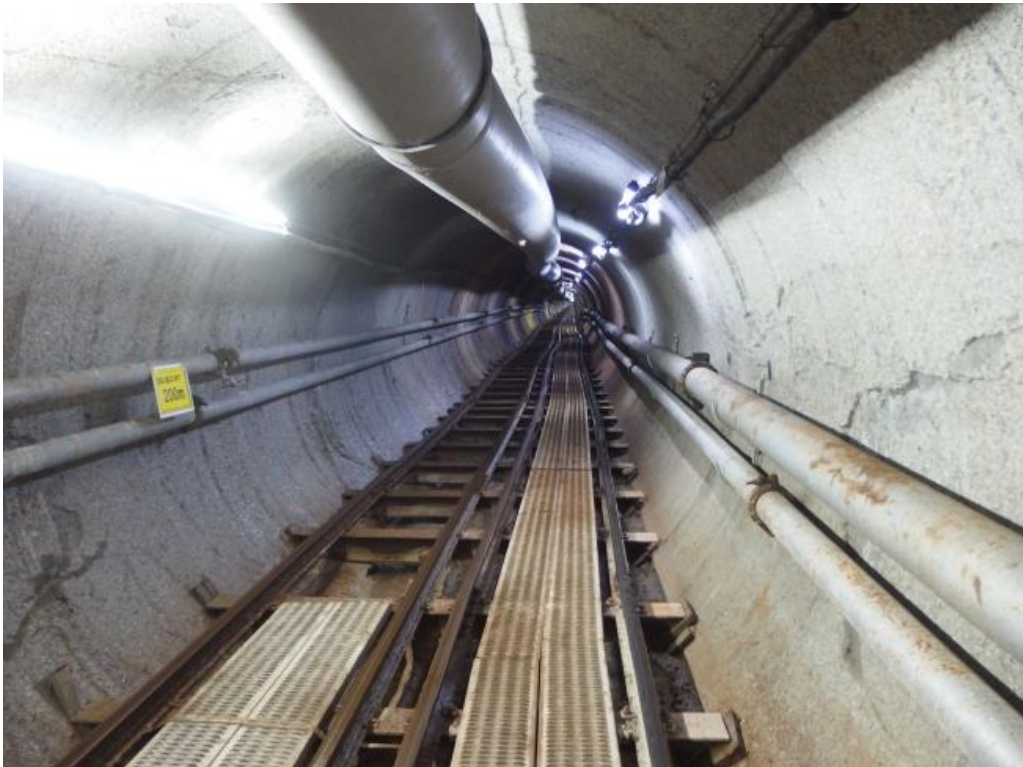
【トンネル坑内】
