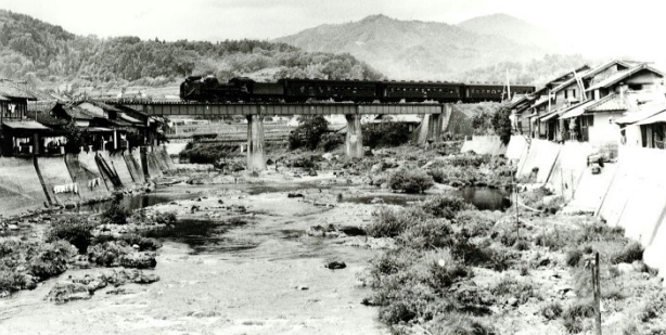
備後西城～平子間にて 第三西城川橋梁を渡る新見発広島行き 昭和42年8月13日 200407-2976
