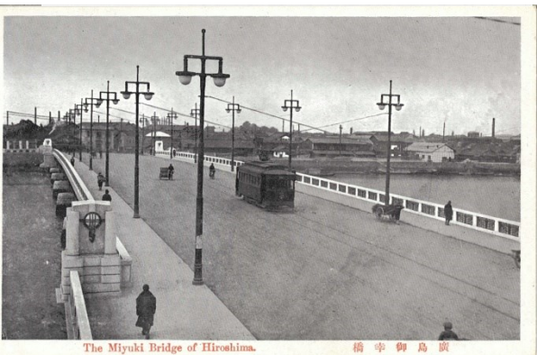
完成間もない御幸橋を渡る 100 形電車 昭和 6 年頃
