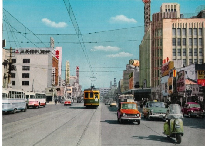
道路拡幅後の八丁堀電車通り 昭和 30 年代
