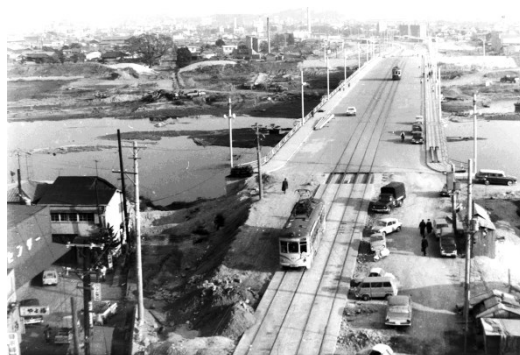
軌道移設が終わった新己斐橋 昭和39年11月28日 200407（フィルムNo.11010）
