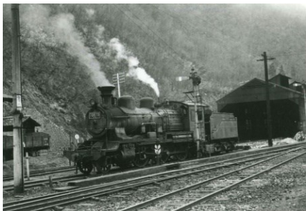
備後落合にて78675 昭和37.3.11 78675は昭和13年に芸備線に配置され、その後昭和45年10月に和歌山機関区へ移転した。昭和47年5月に廃車となったが、奈良県五條市が無償貸与を受け、現在は五條市の史跡公園で静態保存され、現存している。
