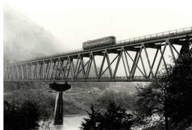
伊賀和志～宇都井間 第三江ノ川鉄橋にて 446D 平成 2.5.4
