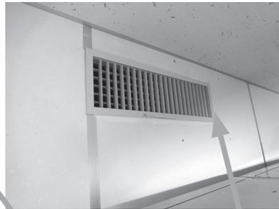
写真8 天井下の壁の空調吹出口
