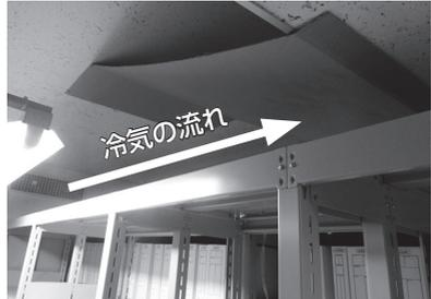
写真36 天井に取り付けた段ボール
