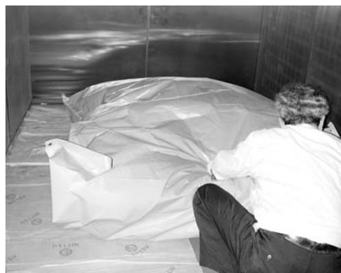
ビニールシートでの密封作業
