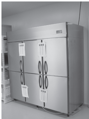
②荷解室の巨大冷凍庫
