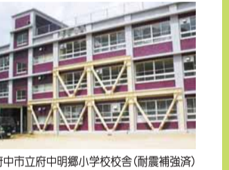
府中市立府中明郷小学校校舎(耐震補強済)
