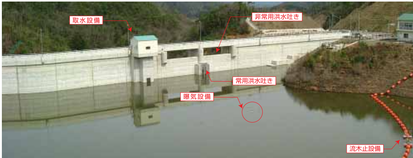
山田川ダム及び貯水池
