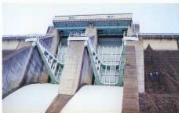
▲クレストゲート 洪水調節用主ゲート
