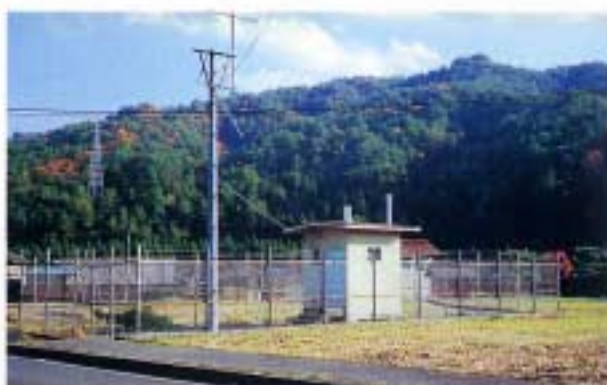
▲雨量観測局 ダム上流（奥栖地点）の雨量データをダム管理事務所へテレメータで集めデータ処理を行うシステム
