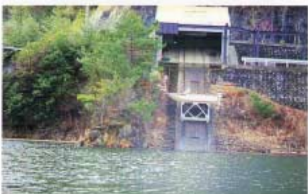
▲繋船設備 遊覧船を艇庫に格納したり揚降しのための設備
