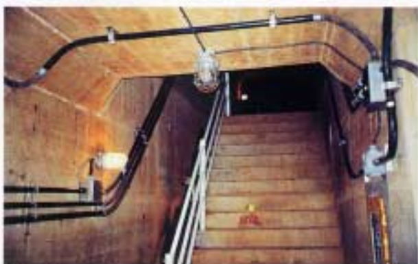
▲監査廊 ダムの境内の点検調査をするための通路
