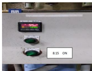
脱水機を、 使用する直前にスイッチ を入れるように変更
