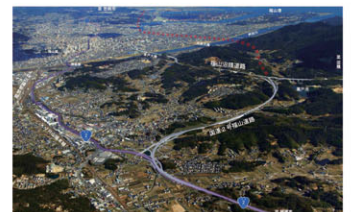
一般国道2号福山道路
