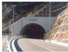
道路改良工事例 (バイパス整備)
