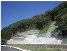
法面災害防除工事例 (法枠工事)
