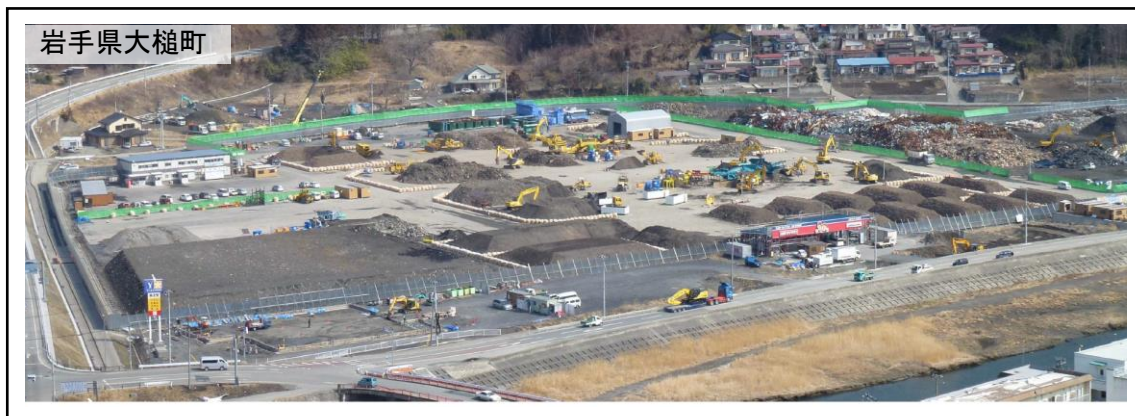
図 2-2-4 二次仮置場の例
