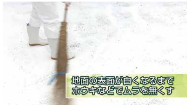
直到地面表面变白为止,用扫帚等消除不均匀。
