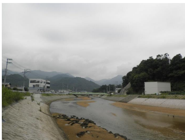
河川改修事業 永慶寺川（廿日市市大野）
