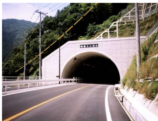
安条トンネル(大竹市安条)
