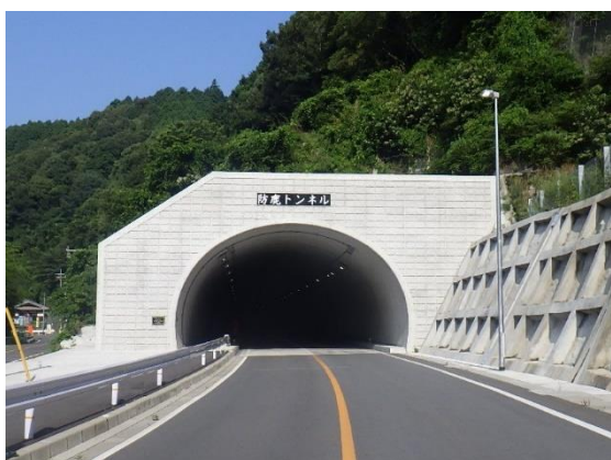
防鹿トンネル(大竹市防鹿)
