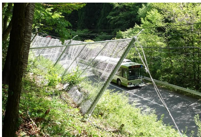
一般国道186号 道路災害防除工事 落石防護網設置 （廿日市市飯山～栗栖）
