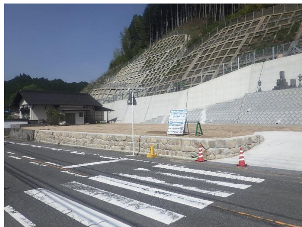
急傾斜地崩壊対策事業 檜原地区 （廿日市市玖島） 令和3年度完成
