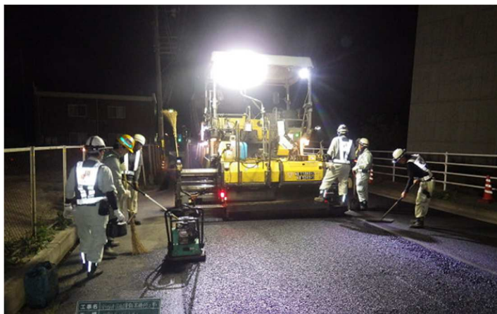
主要地方道 廿日市佐伯線 舗装補修（廿日市市宮内）
