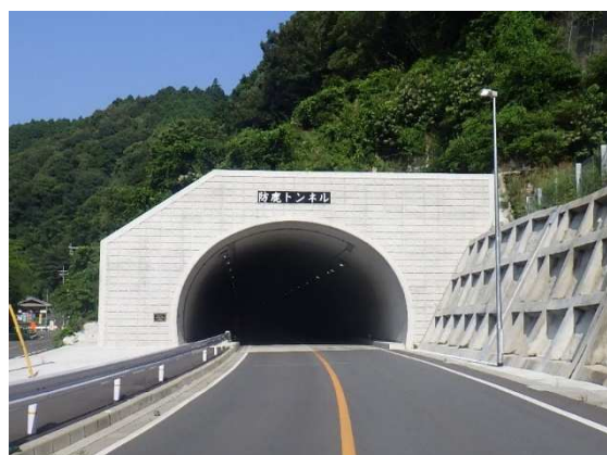
防鹿トンネル(大竹市防鹿)
