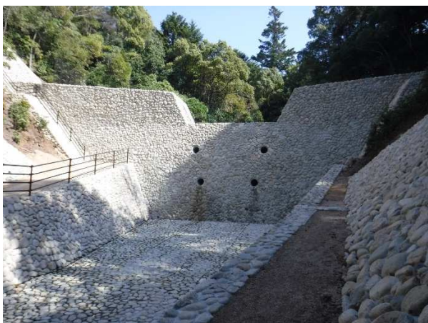
通常砂防事業 縦谷川（廿日市市宮島町） 令和3年度完成
