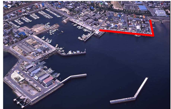
地御前漁港海岸（2工区）
