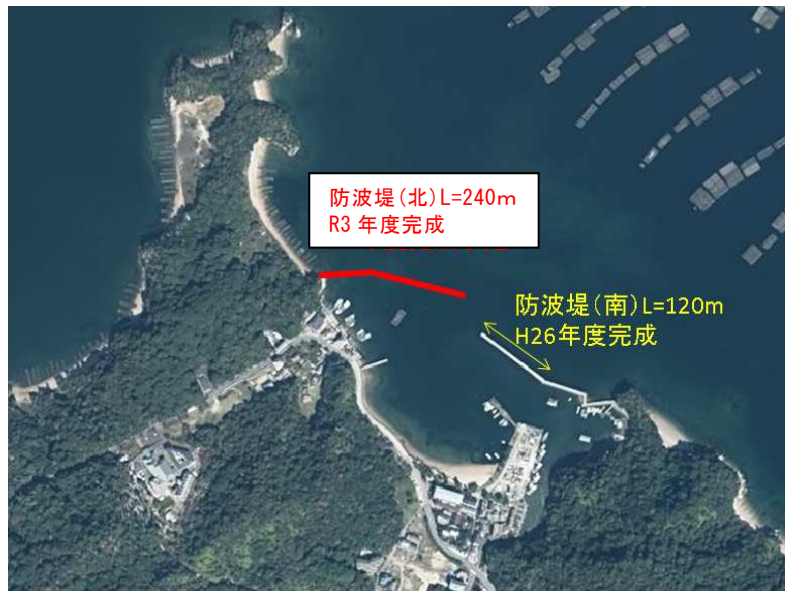
巖島港整備事業（杉之浦地区）
