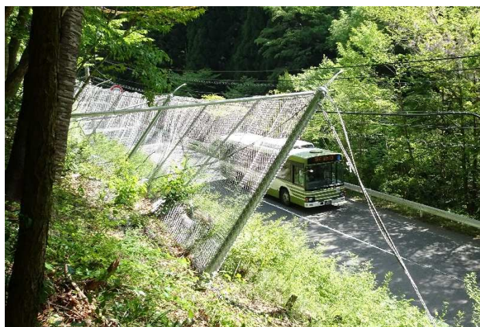
一般国道186号 道路災害防除工事 落石防護網設置 （廿日市市飯山～栗栖）
