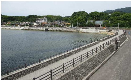
地御前漁港海岸（1 工区）
