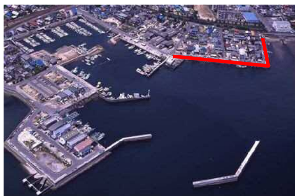
地御前漁港海岸（2工区）
