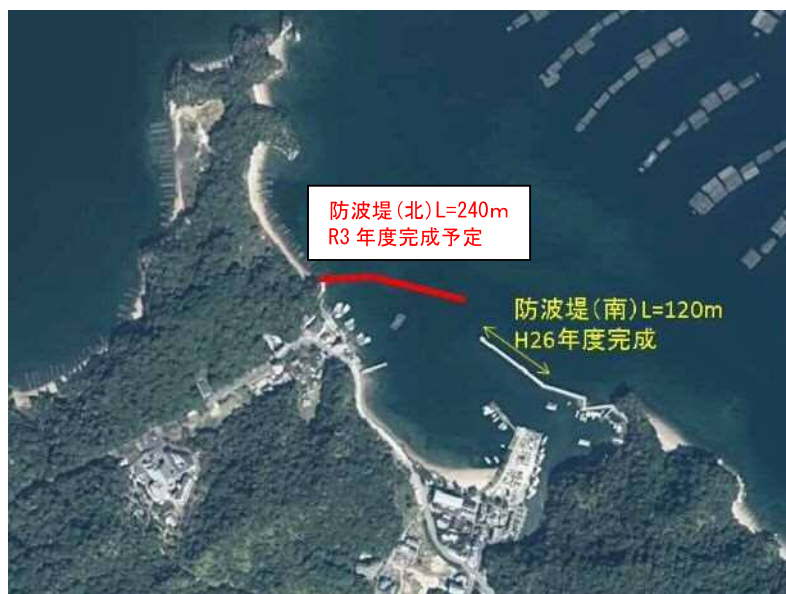
厳島港整備事業 (杉之浦地区)
