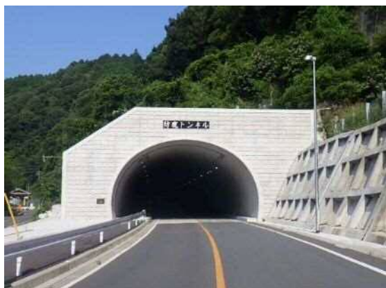
防鹿トンネル(大竹市防鹿)
