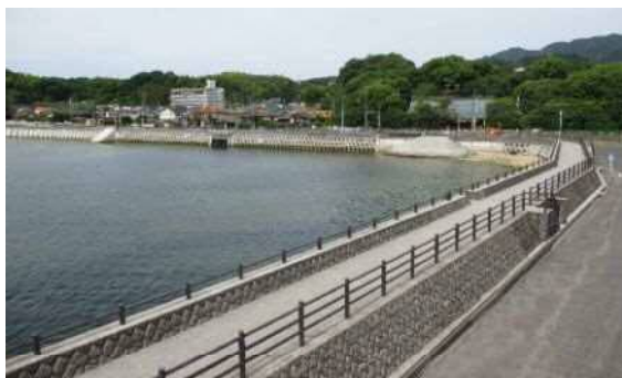
地御前漁港海岸(1工区)
