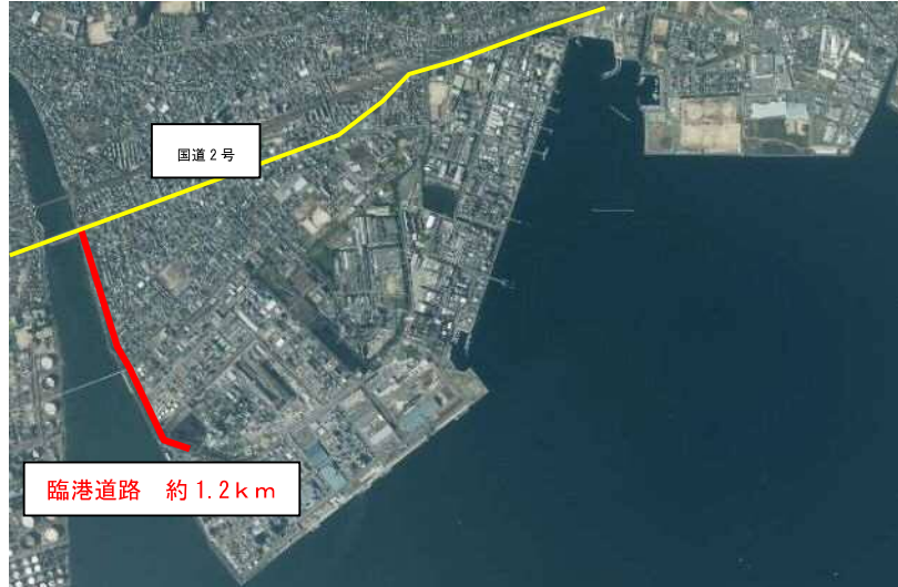
大竹港東栄地区臨港道路整備事業
