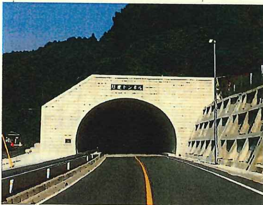
防鹿トンネル(大竹市防鹿)
