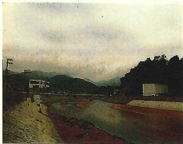
河川改修事業 永慶寺川 (廿日市市大野)
