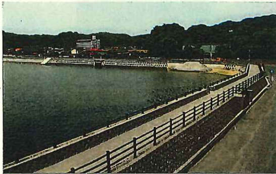
地御前漁港海岸(1工区)
