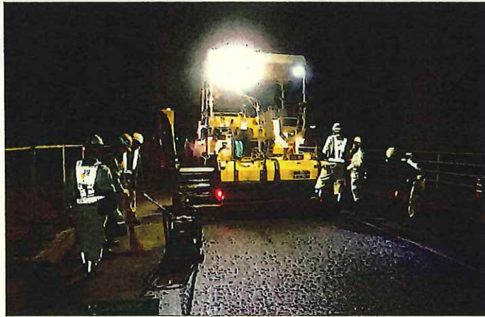
主要地方道 廿日市佐伯線 舗装補修 (廿日市市内)
