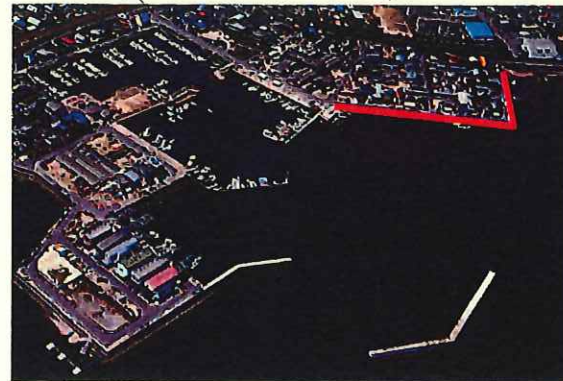
地御前漁港海岸（2工区）
