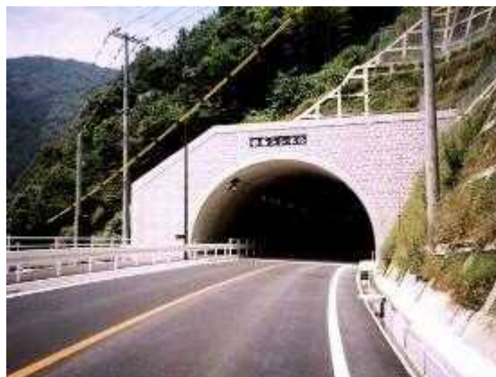
安条トンネル(大竹市安条)
