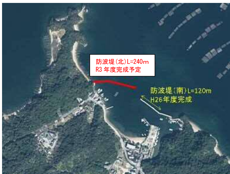
巖島港整備事業 (杉之浦地区)
