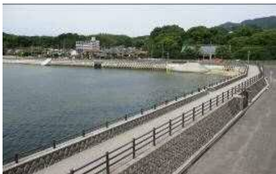
地御前漁港海岸(1工区)
