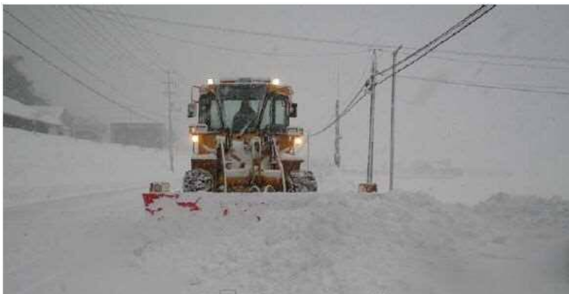
一般国道186号 除雪状況（廿日市市吉和）
