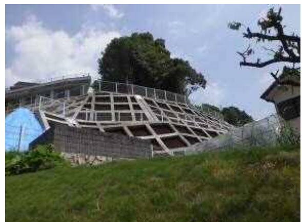
急傾斜地崩壊対策事業 清末地区 （廿日市市佐方）
