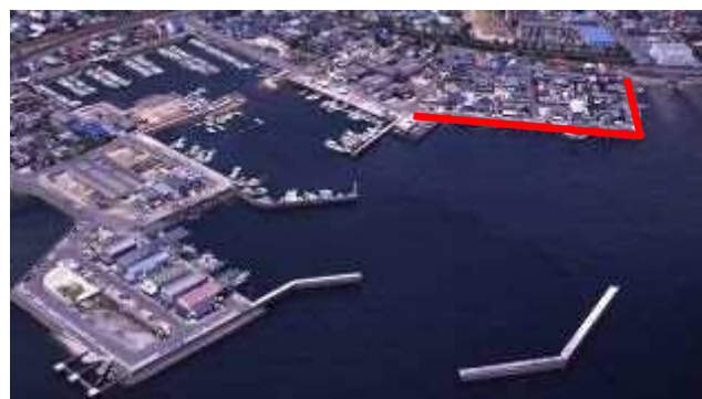
地御前漁港海岸（2工区）
