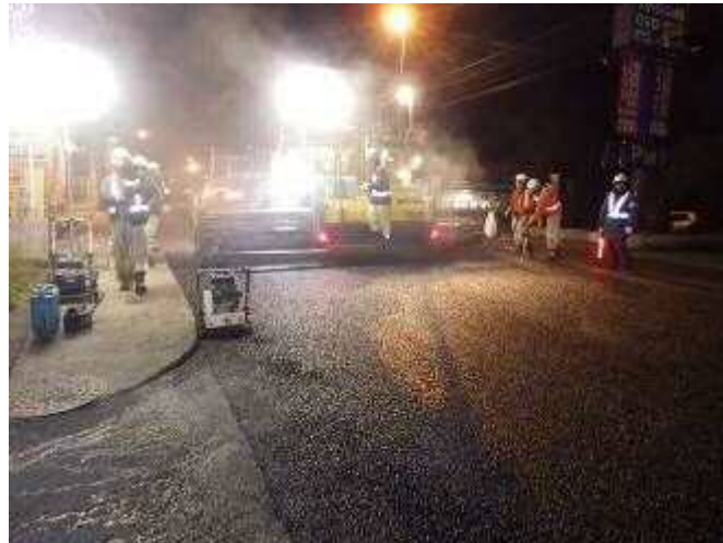
一般国道 2 号 舗装補修（廿日市市串戸）
