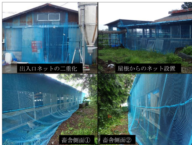
図4 防虫ネット設置状況(令和3年度)
