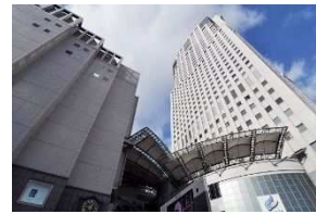
第5位 NTTクレド基町ビル (広島市)
