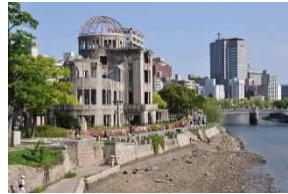
第2位 原爆ドーム (広島市)
