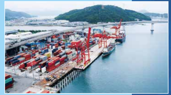
海田コンテナターミナル
