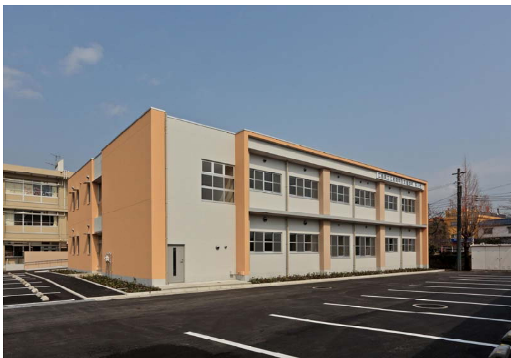
県立広島南特別支援学校呉分校舎（1 2号棟）
