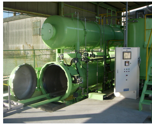
低コスト薬剤の減圧加圧注入
