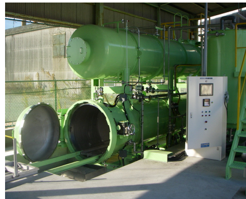
低コスト薬剤の減圧加圧注入
