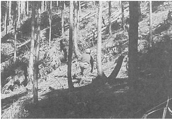
写真4 荷掛け作業 (ワイヤーロープ人力巻上)
