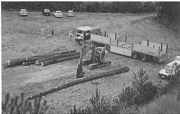
写真4 グラブとトレーラートラック
