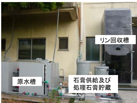
リン回収装置
