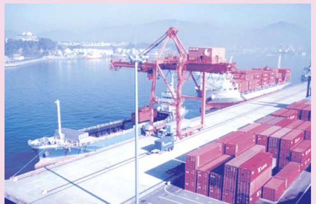
海田コンテナヤード（昭和62年3月）【S05-2002-23-53】 海田湾の埋立は、昭和40年代以来の懸案であったが、昭和60年12月に完成し、流通の拠点として整備された。
