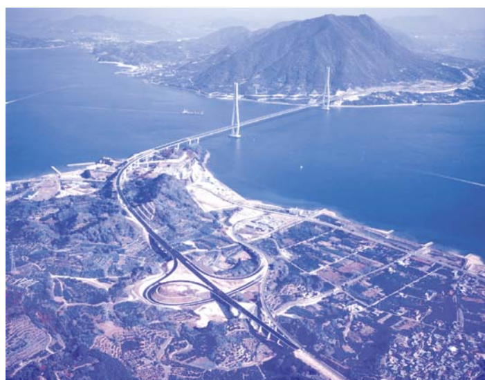
多々羅大橋【豊田郡瀬戸田町（生口島）—愛媛県越智郡上浦町（大三島）】 （平成10年度）【S05-2008-11-6】
