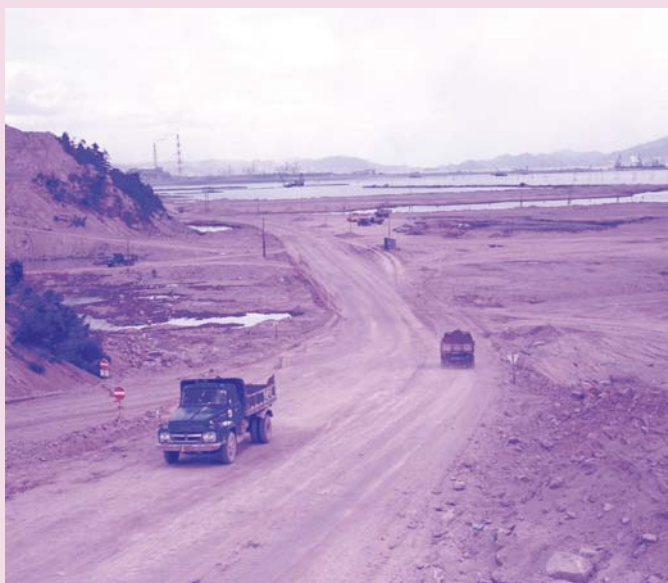
福山市箕島町沖の土地造成工事（昭和46年頃） 【S05-2002-16-6-15】
