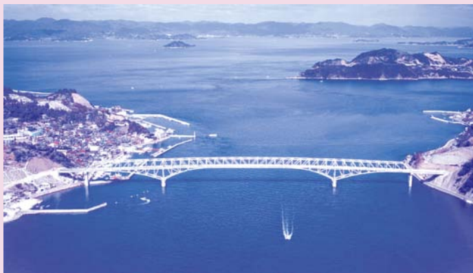
豊浜大橋【豊田郡豊浜町（豊島―大崎下島）】 （平成4年11月開通）【S05-2008-2-5】 安芸灘諸島連絡架橋の一つで、農道橋として整備された。
