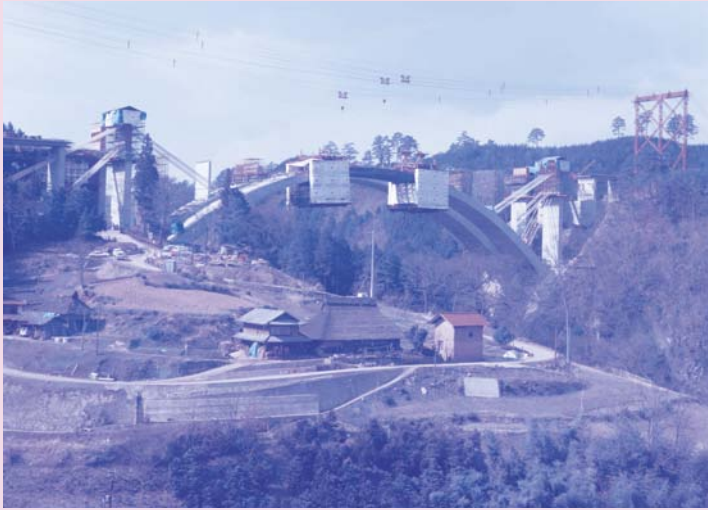
建設中の中国縦貫自動車道帝釈橋 [比婆郡東城町] (昭和53年竣工) 【S05-2002-3092】
