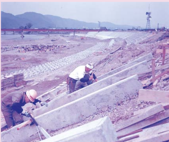
◀ 昭和三十七年七月豪雨の災害復旧工事 【三次市】 (昭和48年4月11日) 【S05-2002-15-8-4】
