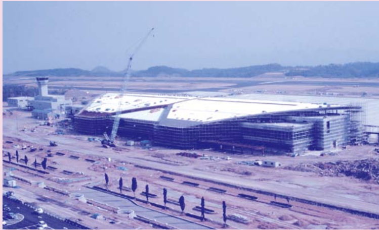
建設中の新広島空港ターミナルビル（平成5年2月28日）【S05-2002-567-1-3】
