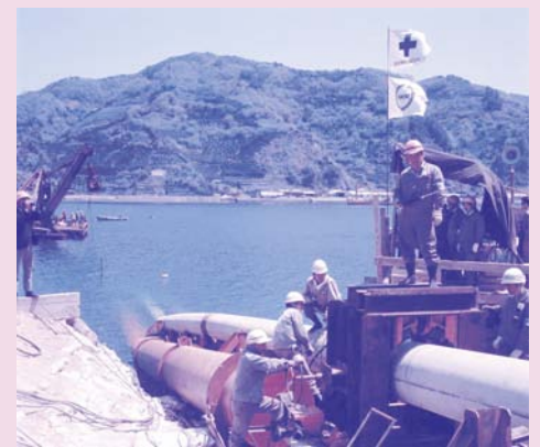
安芸灘地域水道用水供給事業 (昭和47年4月22日)【S05-2002-15-7-9】
