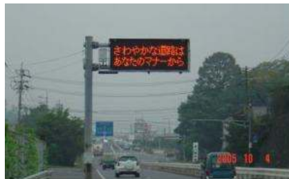
図3 LED式電球を用いた電光掲示板
