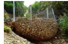
(参考)ワイヤーネットやスリットダムによる土石や流木の捕捉
