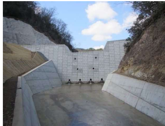
砂防堰堤の整備
