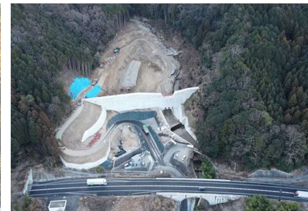
山王川2-2-97溪流砂防堰堤 (広島市安芸区中野東地区)
