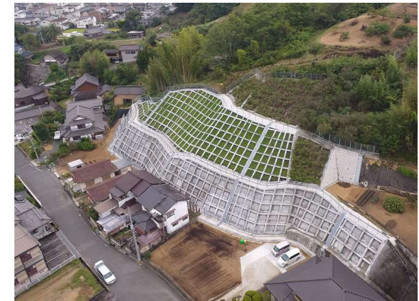
急傾斜地崩壊防止施設の整備
