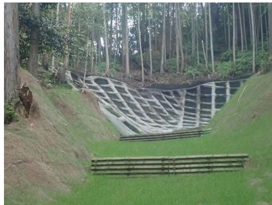
山腹工 施工後の状況(令和5年3月撮影)
