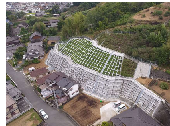
急傾斜地崩壊防止施設の整備
