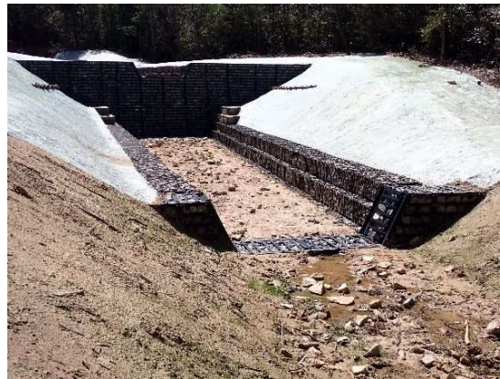
溪間工 施工後の状況(令和5年3月撮影)
