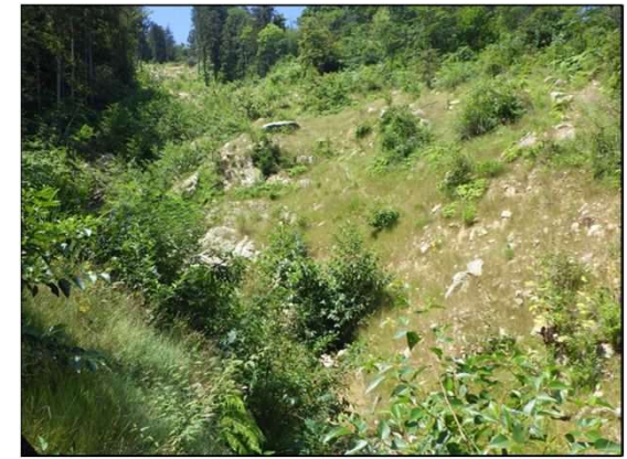
施工9か月後の状況(令和5年7月撮影)
