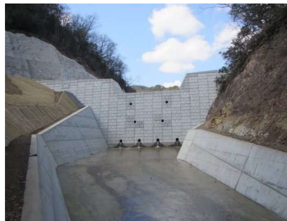
砂防堰堤の整備
