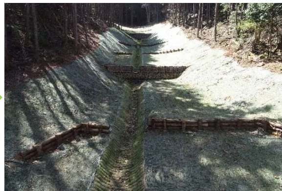
山腹工 施工後の状況(令和5年3月撮影)
