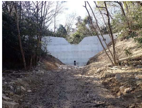
溪間工 施工後の状況(令和5年3月撮影)
