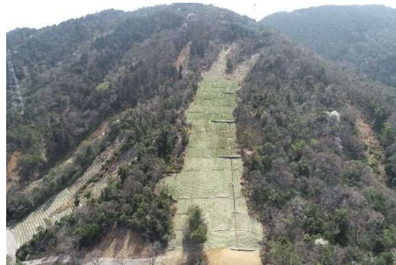
山腹工 施工状況(令和5年3月撮影)
