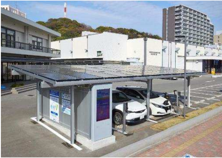
再生可能エネルギーを活用した EVカーシェアリング
