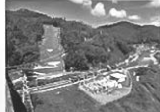
山腹工(東広島市)
