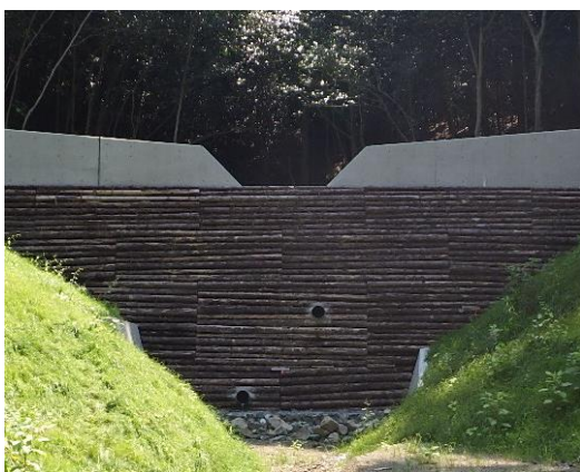
丸太残存型枠（福山市）
