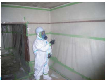
隔離・養生シートへの粉じん飛散防止剤の散布
