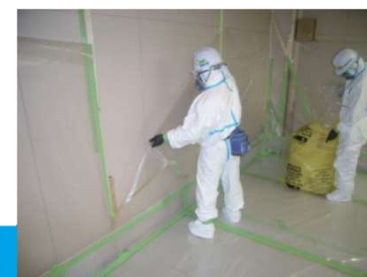
養生シートの撤去
