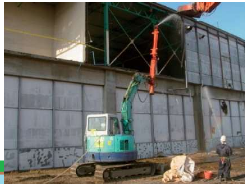
湿潤化の例（散水）
