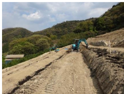
園地整備による植栽の機械化作業 (平成25年3月)
