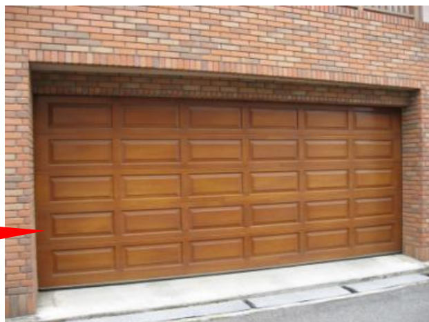
写真2 木製ガレージシャッター施工例（試作）
