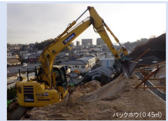
ICT建機による掘削状況
