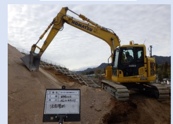
ICT建機による法面整形状況
