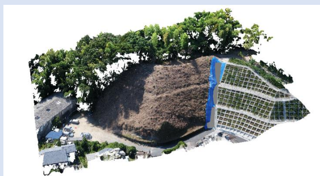
点群データ作成(伐採完了後)
