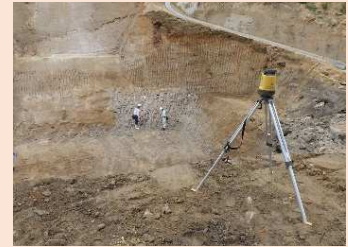
掘削位置確認
