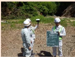
施工位置の確認(県職員)
