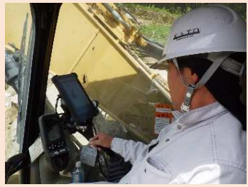
端末を確認する重機オペレーター
