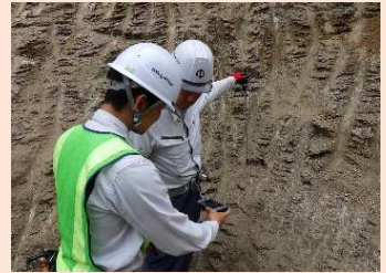
掘削位置確認
