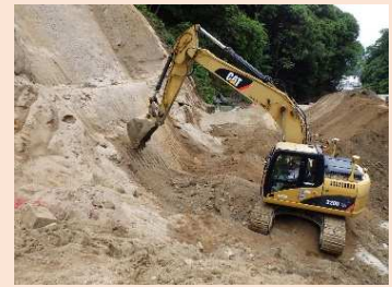
掘削作業状況
