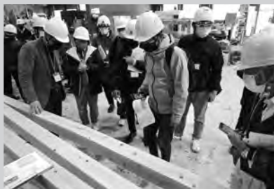
木材の測定実習
