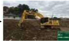
③ ICT建設機械による施工
