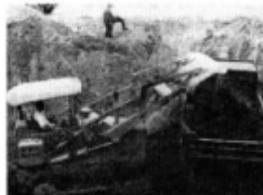
写真3 ブルトーザー、ダンプカーによる掘削作業
