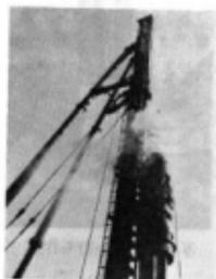
写真1 ディーゼルバイルハンマーによるくい打ち作業
