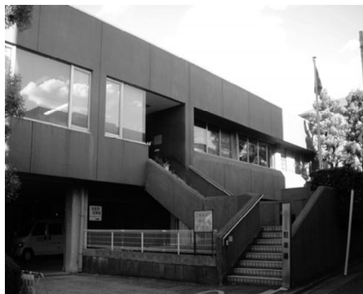
名古屋市上下水道局南営業所
