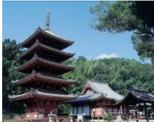
写真 1.2.1 明王院本堂，五重塔
