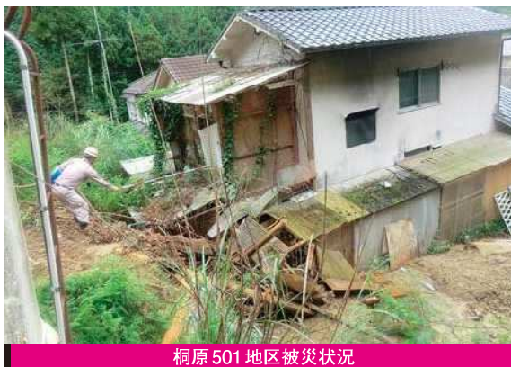
桐原501地区被災状況
