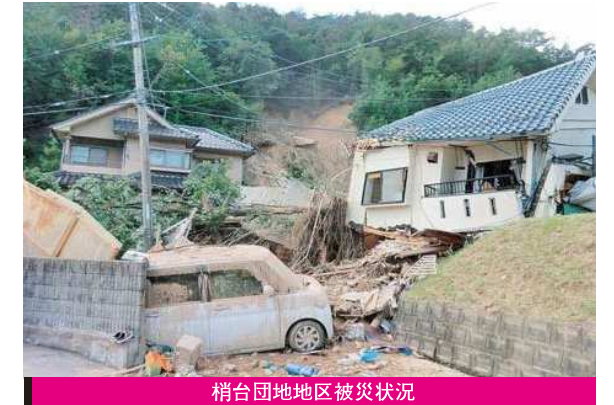
梢台団地地区被災状況
