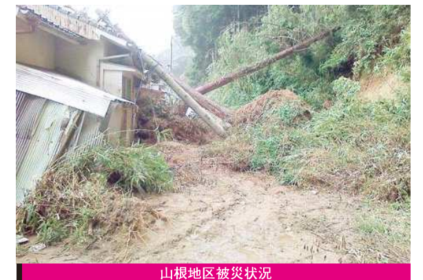
山根地区被災状況
