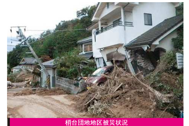
梢台団地地区被災状況
